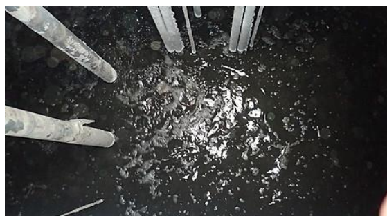
曝気槽の内部
